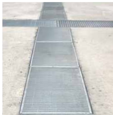
Щелевое покрытие вентиляционных каналов
