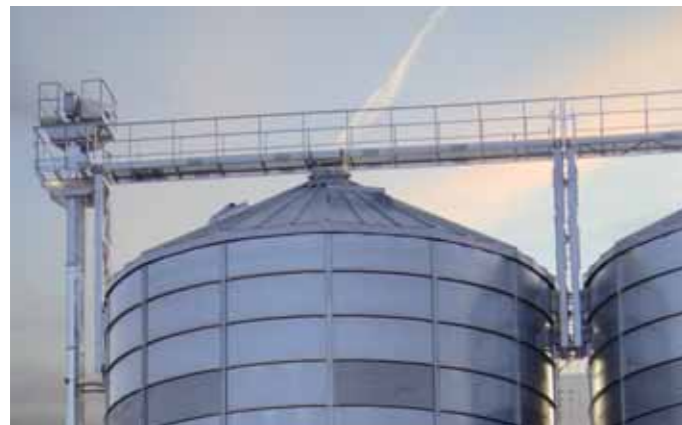
Галерея силоса: стабильно и надежно сконструирована.
