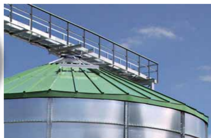
Дождезащитное завершение крыши
