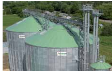
Крыша силоса с порошковым покрытием
