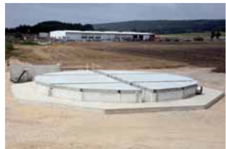
Вентиляционные каналы в фундаменте силоса
