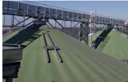
Acoperiș siloz cu strat protector de plastisol
