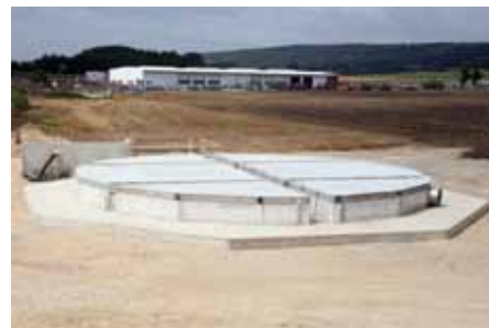
Canale de aerare în fundația silozului
