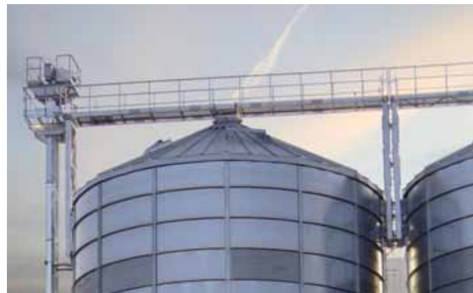
Pasarela siloz- construcție stabilă și sigură
