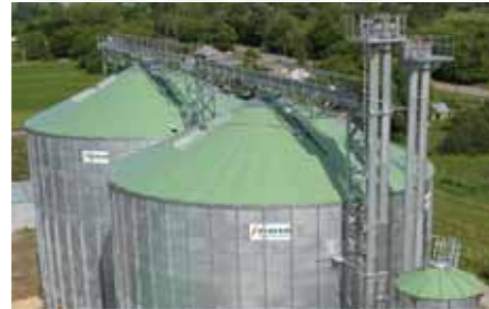
Acoperiș siloz cu strat protector de pulbere plastifiată
